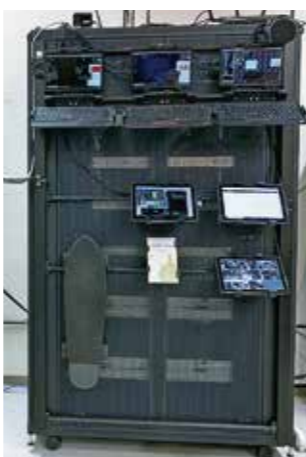
写真1:装置に接続されたサーバー。このサーバーにリモート制御可能とするソフトウェアを組み込んでいる。
